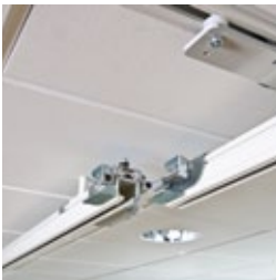
Elektrische railkoppeling.
