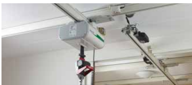
Traverse-systeem met elektrische koppeling.
