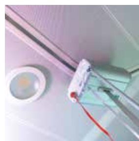
Volledige inbouw rail door middel van kunststof profiel.
